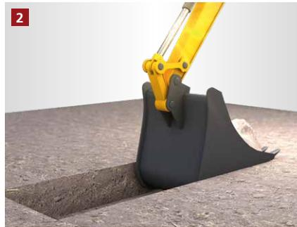
Der Fundamentgraben für die Schalung wird ausgehoben.
