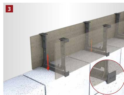
Die zusammengesteckte Schalung wird auf das Mauerwerk gesetzt und ausgerichtet.
