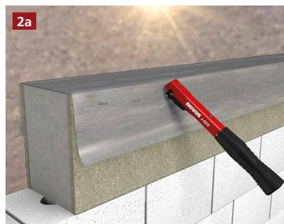
2a Die Folie auf der ungedämmten Schalung mit Hammertacker und Feindrahtklammern befestigen. Klammern nach Aushärten vollständig entfernen.
