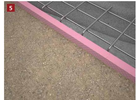
Der Betoniervorgang wird begonnen. (Bei Fuß außen: Schalung gegebenenfalls weiter mit Erde / Sand anfüllen.)
