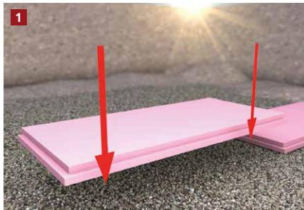
Die Bodenelemente werden nach Bedarf, auf dem vorgefertigten Untergrund, verlegt und verklebt. Bei mehreren Lagen muss auf Fugenversatz geachtet werden.
