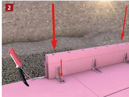
Der Pistolenschaum wird aufgetragen, die Schenkel werden in den Schaum gedrückt und verschraubt.
