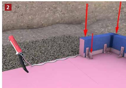
Der Montageschaum wird aufgetragen, die Ecken werden in den Schaum gedrückt und verschraubt.
