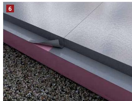
Nach dem der Beton abgebunden ist, wird die Abdichtungsbahn auf dem Beton und um die nun freiliegende Kante aufgetragen.
