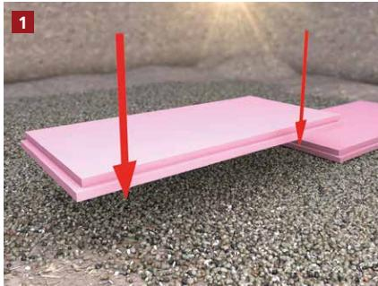
Die Bodenelemente werden nach Bedarf, auf dem vorgefertigten Untergrund, verlegt und verklebt. Bei mehreren Lagen muss auf Fugenversatz geachtet werden.
