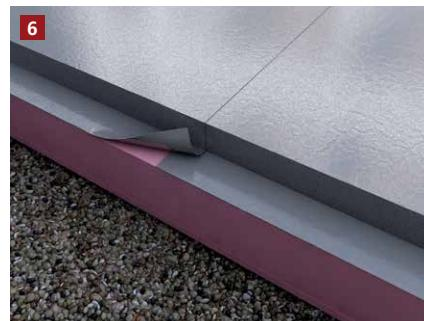
Nach dem der Beton abgebunden ist, wird die Abdichtungsbahn auf dem Beton und um die nun freiliegende Kante aufgetragen.
