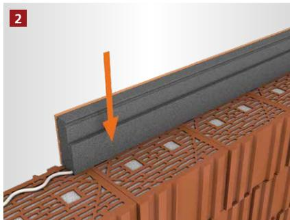
Der äußere Schenkel wird aufgesetzt und ausgerichtet.
