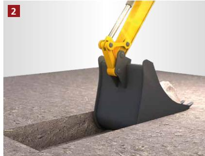
Der Fundamentgraben für die Schalung wird ausgehoben.
