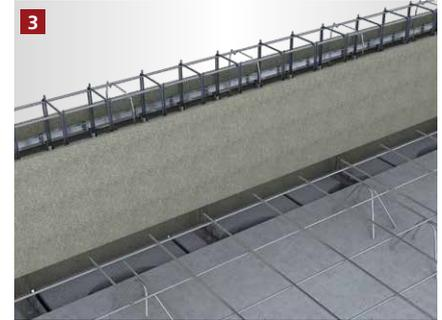
Der Bewehrungskorb wird eingelassen und die erforderliche Deckenamierung eingebunden. Dabei ist stets auf ausreichende Betondeckung zu achten.
