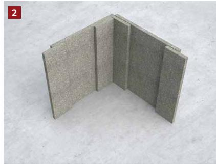
Zuerst wird das Element im 90° Winkel geknickt.
