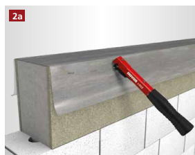
Die Folie auf der ungedämmten Schalung mit Hammertacker und Feindrahtklammern befestigen. Klammern nach Aushärten vollständig entfernen.
