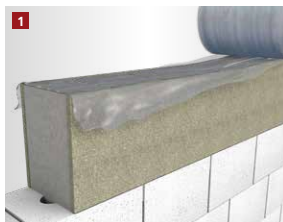
Die Schalung nach dem Betonieren mit der Folie abdecken.
