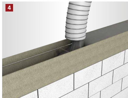
Der Betoniervorgang kann begonnen werden.
