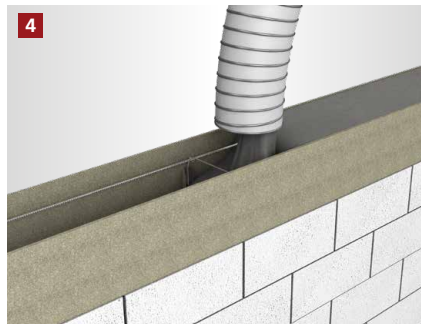
Der Betoniervorgang kann begonnen werden.
