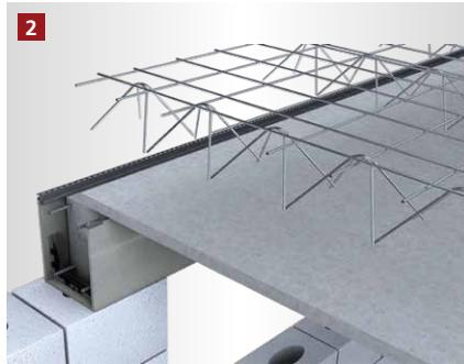
2. Nachdem die Schalung ausbetoniert ist, wird die Filigrandecke aufgesetzt und die Bewehrung ausgelegt. Durch diese Vorgehensweise können Sturz und Decke mit einer Schalung ausbetoniert werden, ohne dass der erhöhte Außenschenkel beim Einlegen der Bewehrung hinderlich ist.
