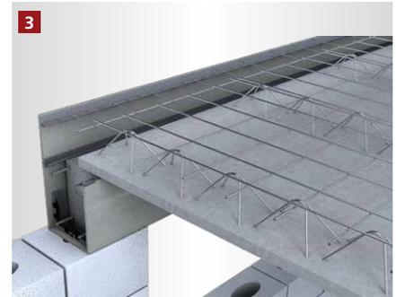
3. Sobald die Bewehrung ausliegt, wird die Schenkelerhöhung in das Erhöhungprofil eingesetzt und verschraubt. Nach Rückverankerung zur Filigrandecke kann die Decke ausbetoniert werden.
