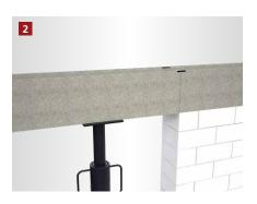
Die Schalung wird mit der entsprechenden Anzahl an Stützen abgestützt.
